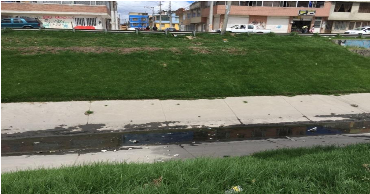
Figura 18. Zona de intervención en el costado suroccidental del Canal Calle 38 sur a la altura de la Carrera 90A. Fuente: SCASP, SDA, 08 de junio de 2016.
