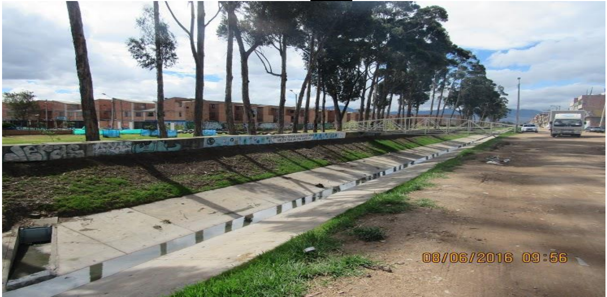
Figura 5. Canal Calle 38 sur visto de noroccidente a suroriente desde el punto de intervención de la Carrera 99B Bis. Fuente: SCASP, SDA, 08 de junio de 2016.
