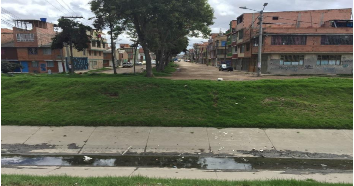
Figura 17. Zona de intervención en el costado nororiental del Canal Calle 38 sur a la altura de la Carrera 90A. Fuente: SCASP, SDA, 08 de junio de 2016.
